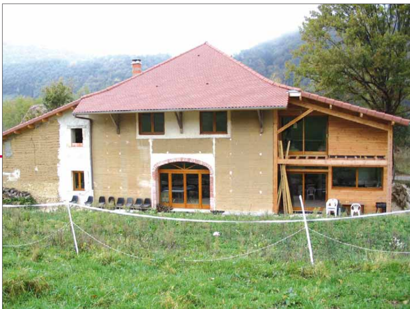
Le pisé est l'un des modes de construction en terre crue étudié dans le projet
