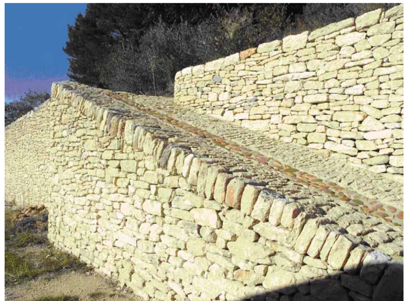
Le mur poids en pierre sèche a de nombreuses applications en génie civil et en bâtiment.
