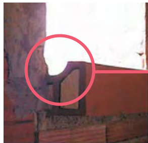
Absence de retour maçonné sur l'appui de menuiserie. Un colmatage précaire à l'aide de joint silicone permet d'assurer temporairement une étanchéité qui va se dégrader avec le temps
