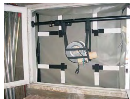
Essai du cadre d'étanchéité prototype Vue de l'intérieure
