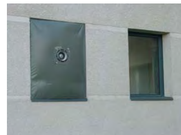
Cadre d'étanchéité du prototype Vue de l'extérieur
