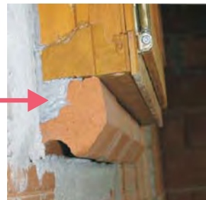
Absence de retour maçonné sur l'appui de menuiserie. Un colmatage précaire à l'aide de joint silicone permet d'assurer temporairement une étanchéité qui va se dégrader avec le temps
