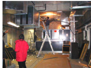
Travaux de rénovation en CTA
