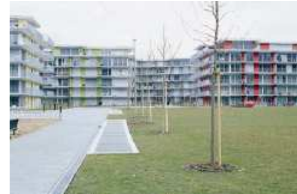
Résidence à Winterthur . P = 1000 kW
