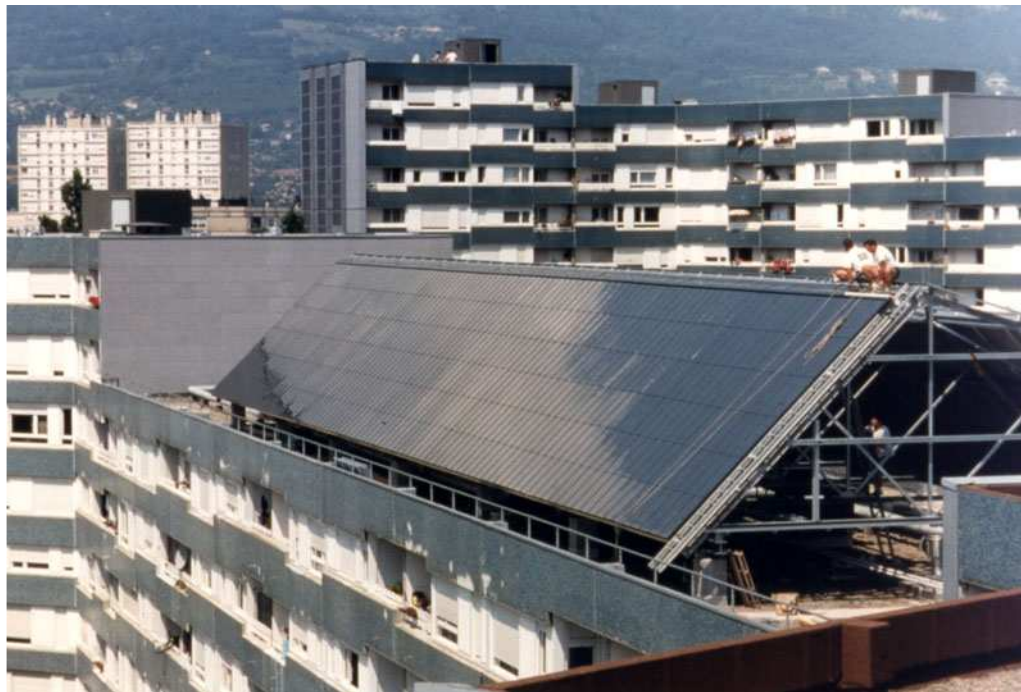
Surieux (99) : 700 m 2 de capteurs
