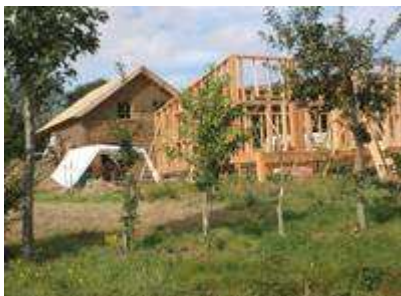
« Aménagement d'un lotissement de la Prairie Madame » Langouët (35)
