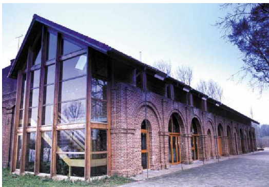
Réhabilitation du centre technique et administratif du parc de la deûle, Houplin-ancoisne (59)
