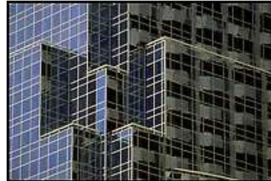
**Faible masse thermique + gains solaires élevés → utilisation importante d'énergie pour maintenir les conditions de confort d'été**
