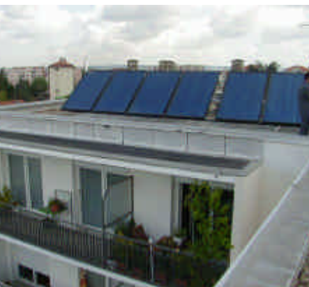
Les capteurs solaires
