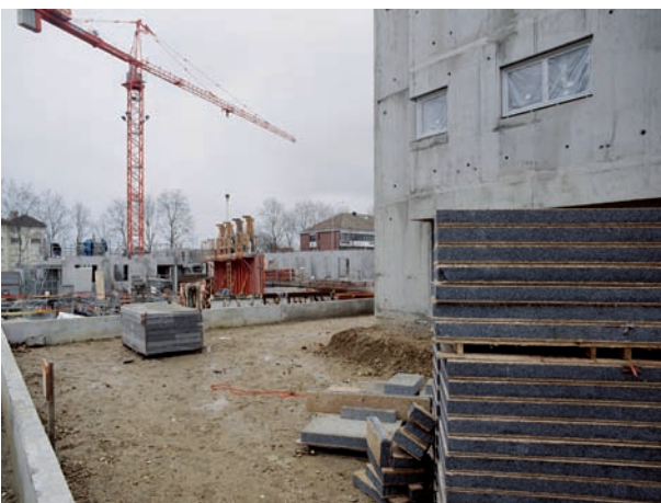
L'opération en chantier
