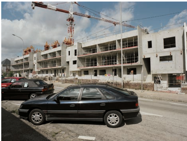
L'opération en chantier
