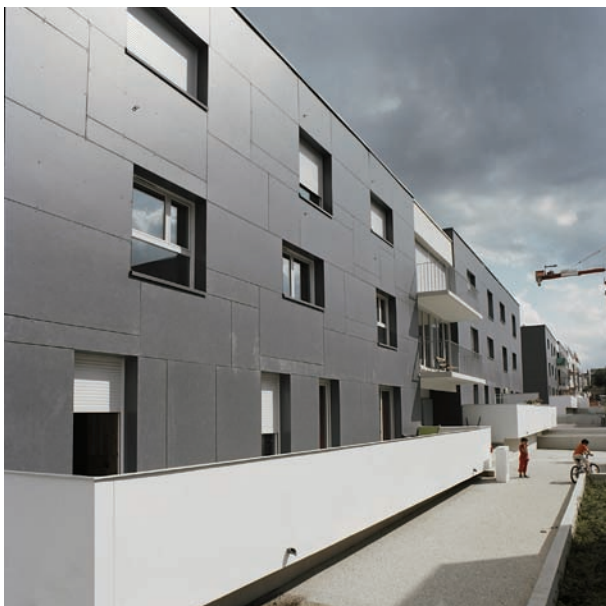
Façade arrière des bâtiments en Eternit
