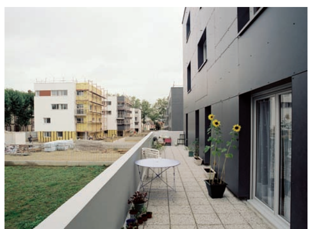
Pose de l'isolation par l'extérieur
