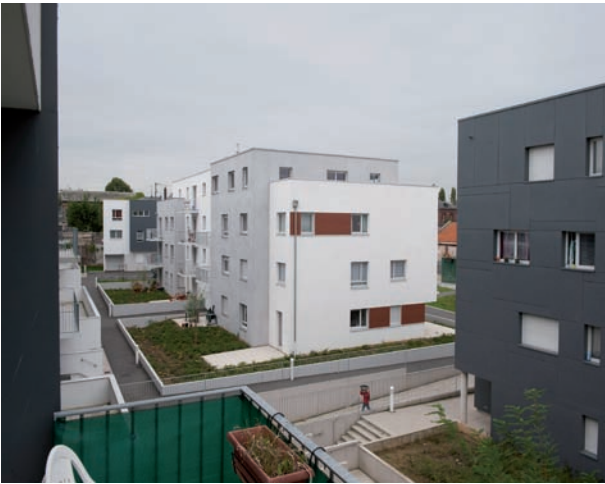
Vue depuis un logement du programme locatif achevé
