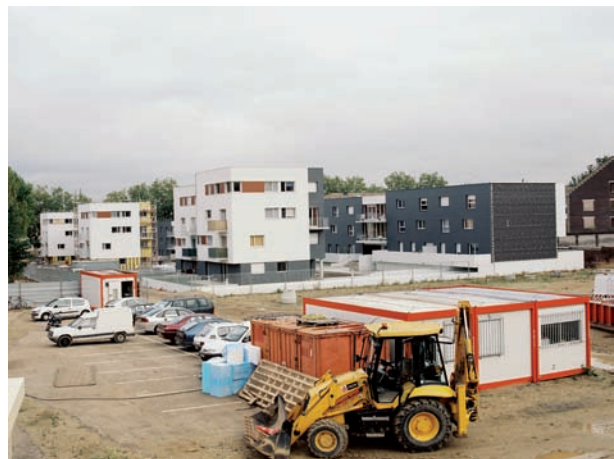
L'opération en chantier
