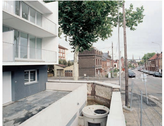
Les douves de stockage
