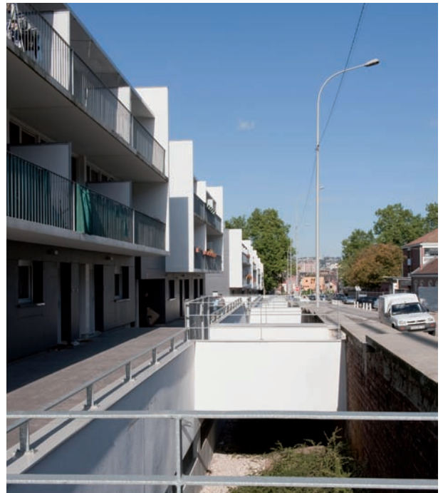
Les douves de stockage
