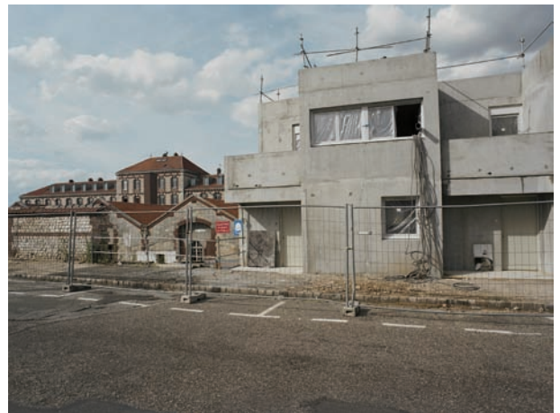
Construction de la tranche en accession et l'ancienne caserne
