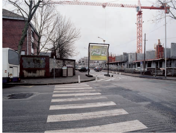
L'opération en chantier
