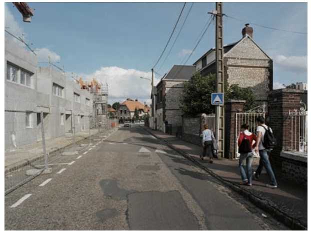
Construction de la tranche en accession
