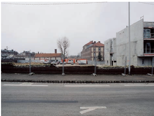
L'opération en chantier et l'ancienne caserne
