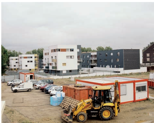
L'opération en chantier
