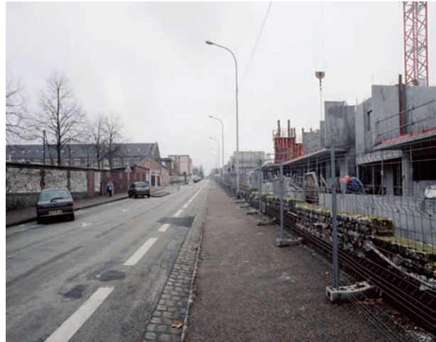
L'opération en chantier
