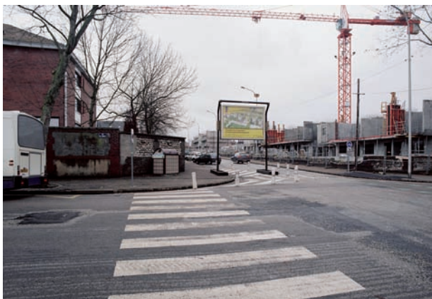
L'opération en chantier
