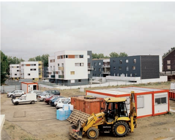
Vue générale de l'opération en chantier
