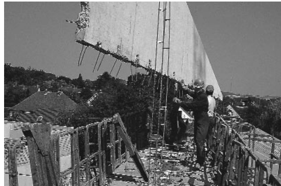
La pose de la pointe préfabriquée
