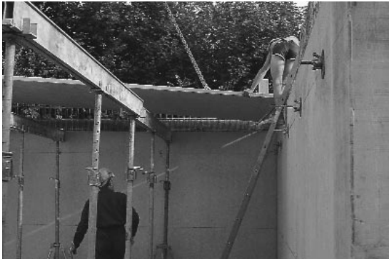
La pose de la première prédalle
