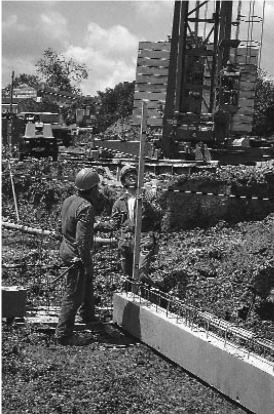
La pose des longrines : un travail de précision
