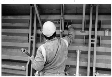
pour la BSBI), d'innovation en rupture avec les coffrages traditionnels. De fait, les (nombreux) apports techniques - dont le plus saillant consiste en un système de roulage permettant d'ouvrir et de fermer le coffrage sans recourir à la grue - ne modifient pas radicalement les habitudes de travail acquises par les compagnons mais, en revanche, facilitent l'organisation du travail des équipes de bancheurs.
