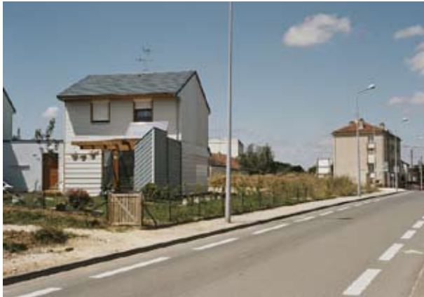
Bourges, seule opération VUD où l'ECS est produite par le solaire
