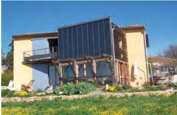
Orientation sud, serre bioclimatique et intégration de panneaux solaires, un exemple d'architecture bioclimatique passive de maison individuelle
