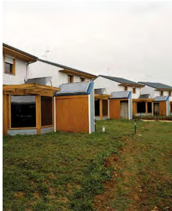
Intégration des panneaux solaires pour le préchauffage de l'eau chaude sanitaire
