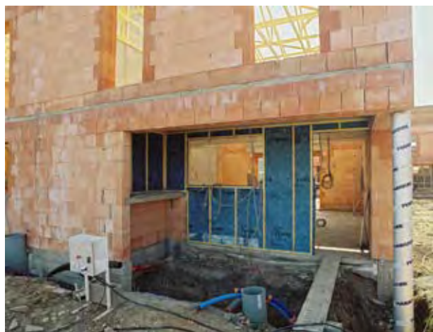
Des bâtiments construits en monomur
