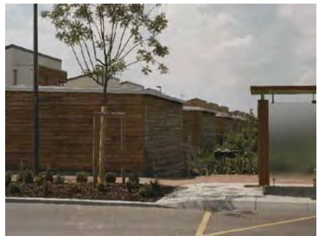
La conception des garages en structures légères en bois intègrent la place de la voiture dans le paysage Eric BERNATH
