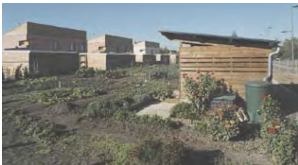
Au premier plan, les cuves pour la récupération de l'eau de pluie
