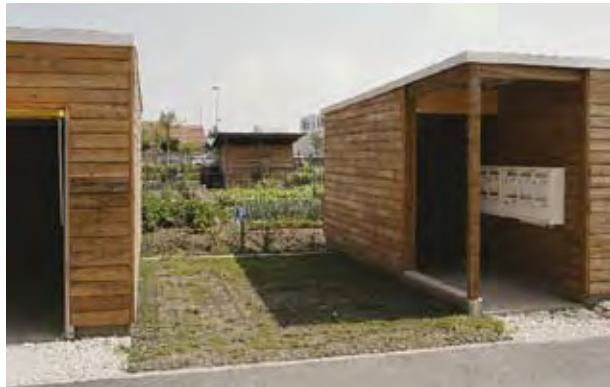
Garages et stationnements à l'air libre en evergreen
