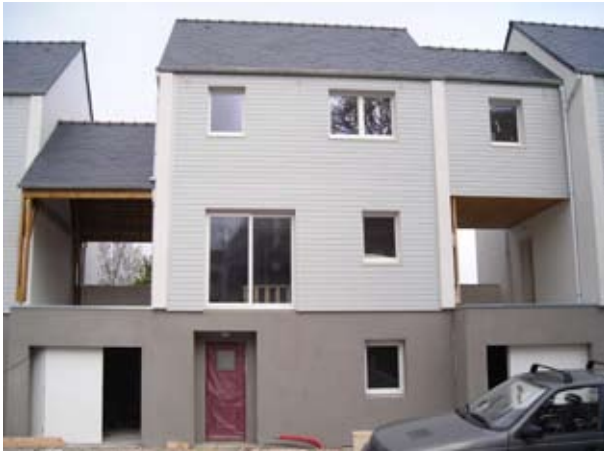
Chantier VUD Quimper en cours d'achèvement
