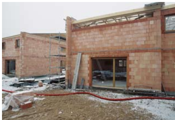
Maçonnerie en monomur
