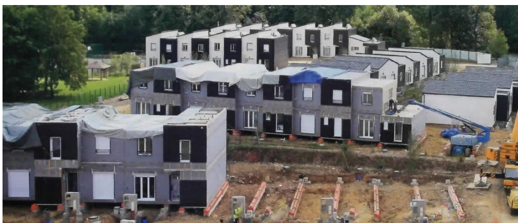
Chantier de Vert-Saint-Denis, 75 logements "Muse", été 2011
