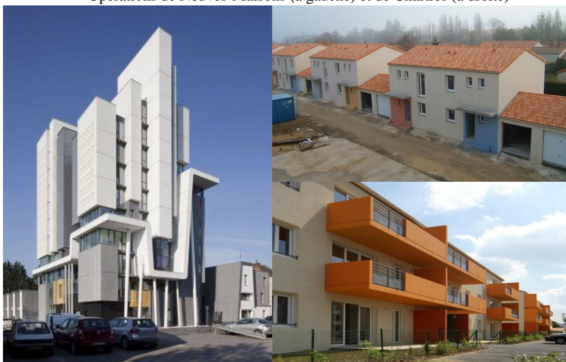
Opérations de Béthune (à gauche) et de Parthenay (haut et bas à droite)
