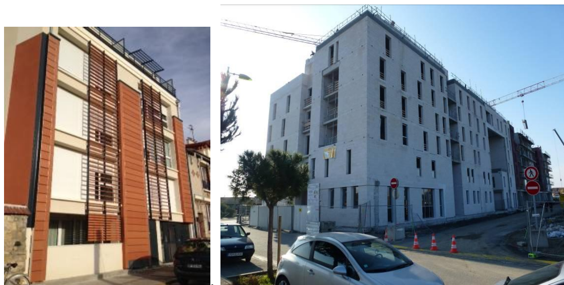
Opérations de Vincennes (à gauche) et de Toulouse-Borderouge (à droite)
