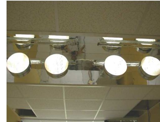
Mise en place des tubes de lumière
