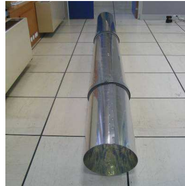
Assemblage des tubes par cerclage
