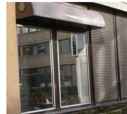
Installation de l'héliostat
