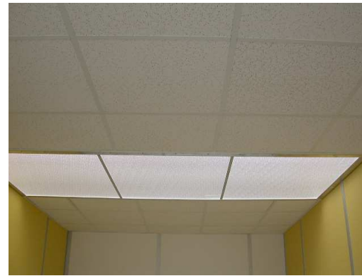
Pose du diffuseur
