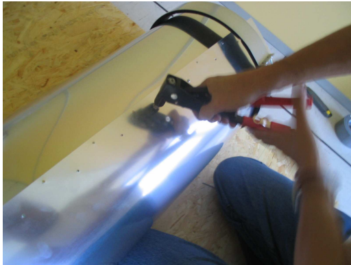
Réalisation des tubes de lumière
