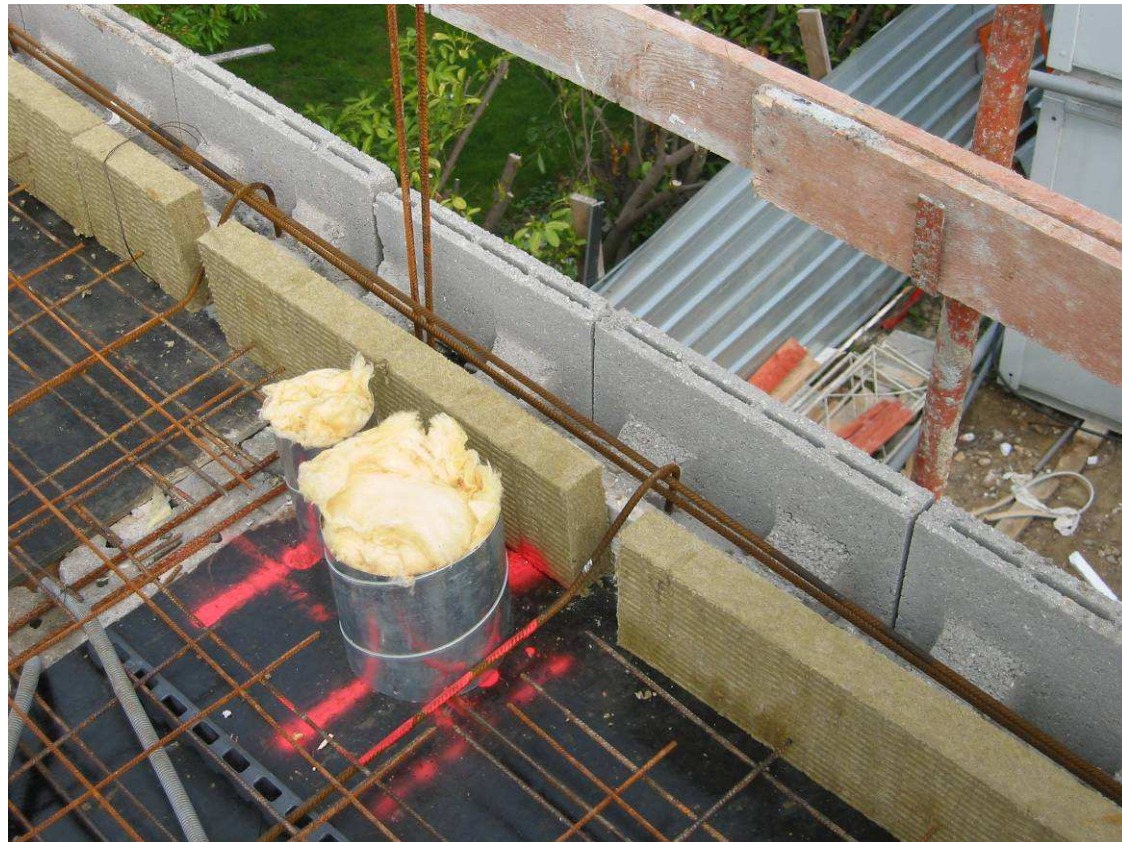
Le rupteur de pont thermique Bouygues en façade maçonnée
