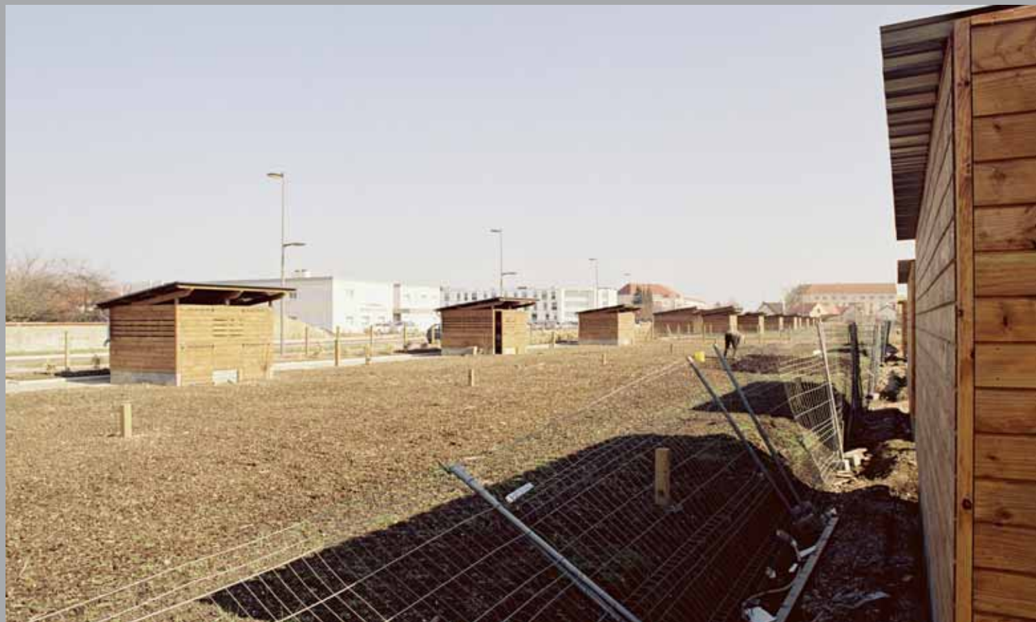
Des jardins ouvriers à l'arrière des garages, avec des abris de jardin en structure légère bois
