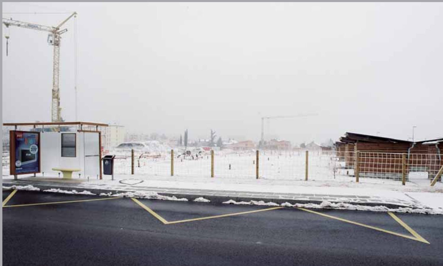
Vue sur les abris de jardin en chantier et sur l'arrêt de bus localisé aux portes du quartier
