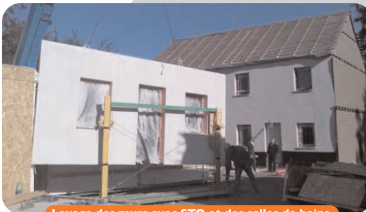
Levage des murs avec STO et des salles de bains
