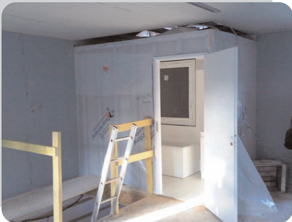
Mise en place des plafonds et des gaines électriques
