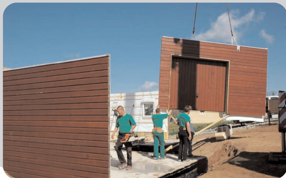
Levage et pose des murs
