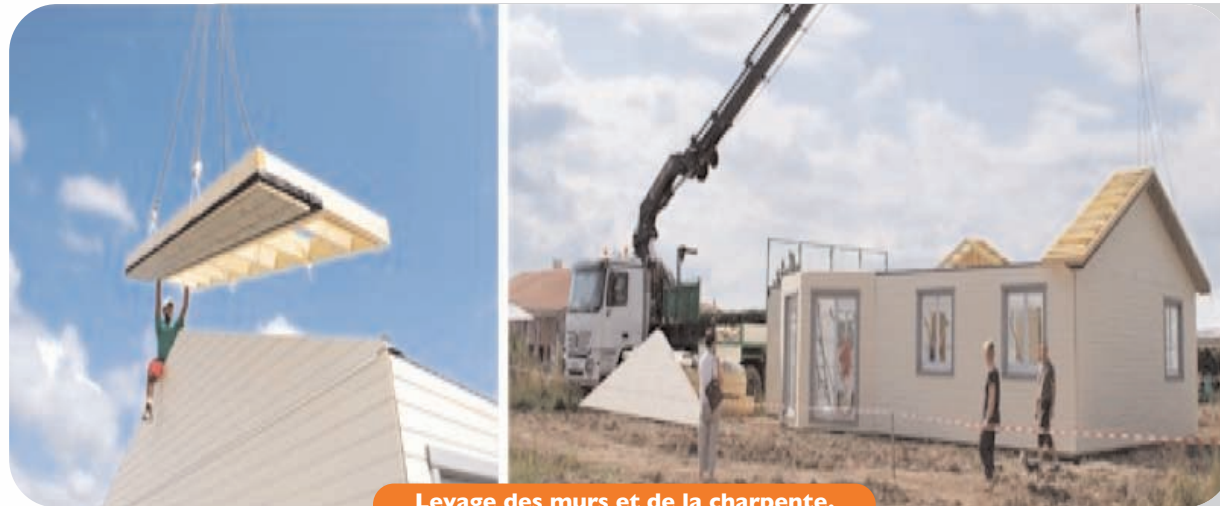
Levage des murs et de la charpente.
