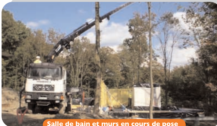
Salle de bain et murs en cours de pose
