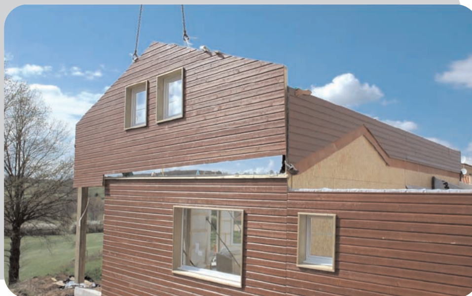
Levage et pose des murs
